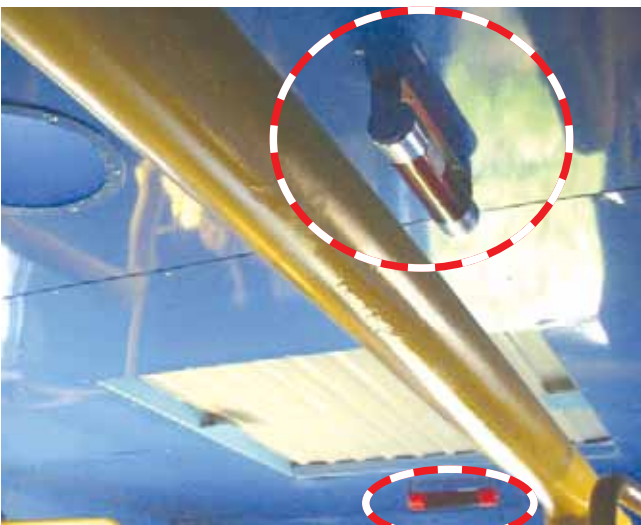
Εφαρμογή της αμπούλας BONPET σε οροφή μηχανοστάσιου
