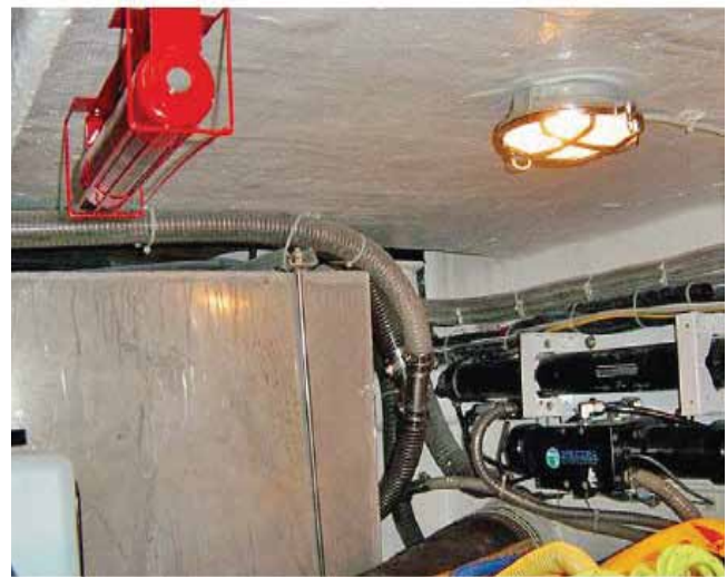
Εφαρμογή της αμπούλας BONPET κοντά σε ηλεκτρονικούς εξοπλισμούς που είναι αδύνατον να καλυφθεί με συστήματα ολικής κατάκλισης
